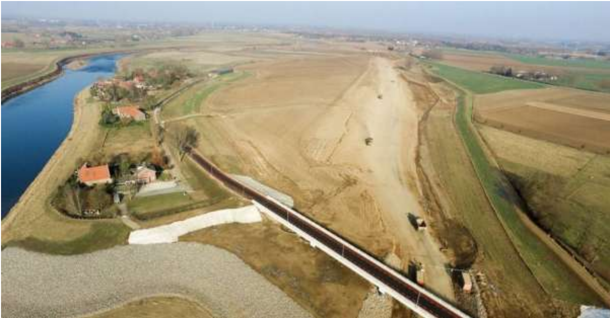
Figuur 1.3.1. Aanlegfase nevengeul bij Visserweert met de bijbehorende hoogwaterbrug. 10
