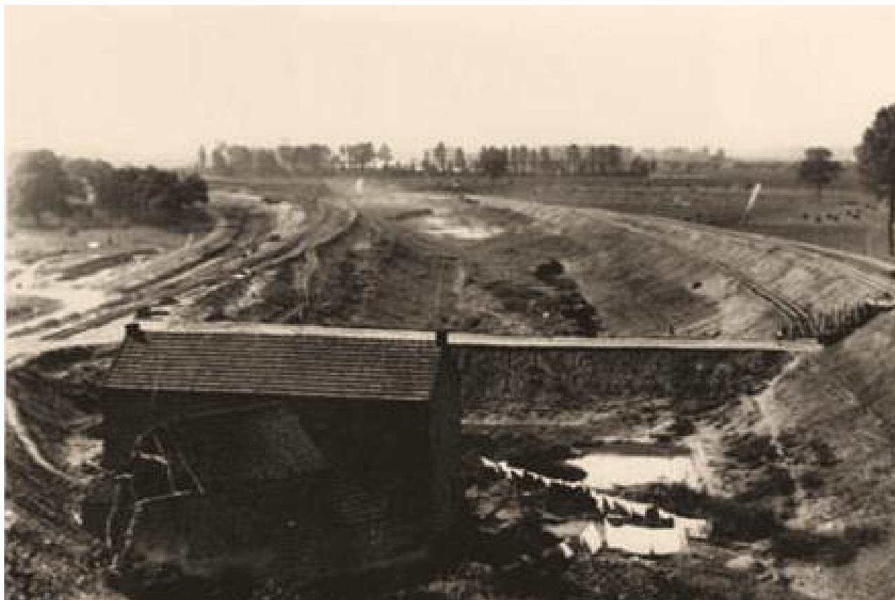
Afb. 34. Foto van de aanleg van het Julianakanaal genomen in de nabijheid van Elsloo. Bij Elsloo moest voor de aanleg van het kanaal de helft van het dorp worden afgebroken
