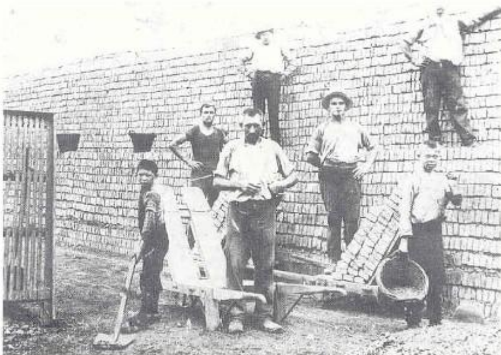
Afb 30. brikkenbekkers bij het stapelen van de stenen voor een veld-brandoven
