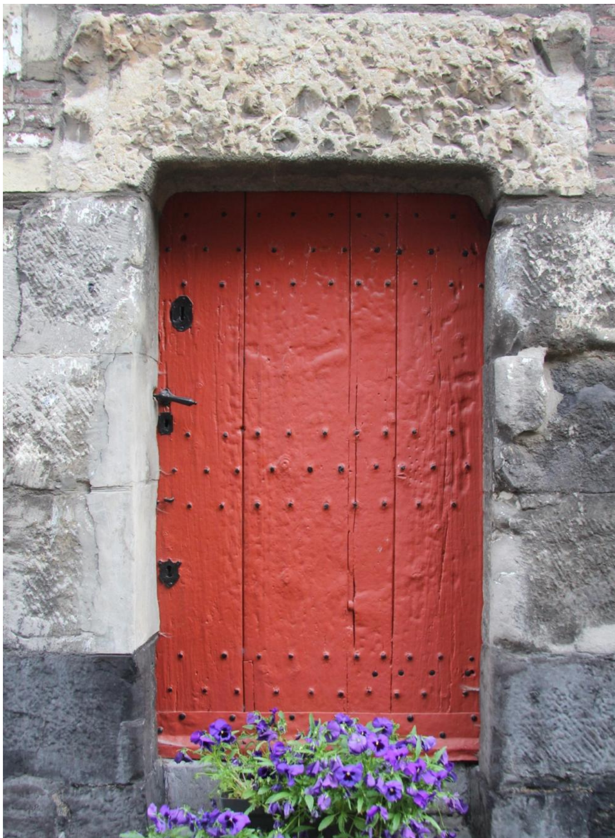
Afb. 3 Historische deur in de zijgevel van het Scippershuis te Elsloo
