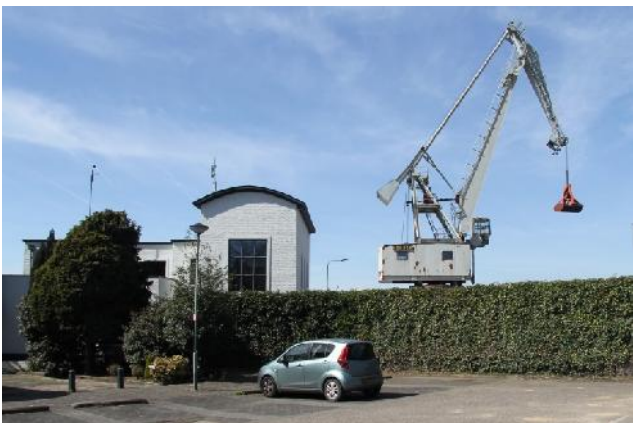
Afb. 20 Het havengebouw en de hijskraan in de haven van Stein
