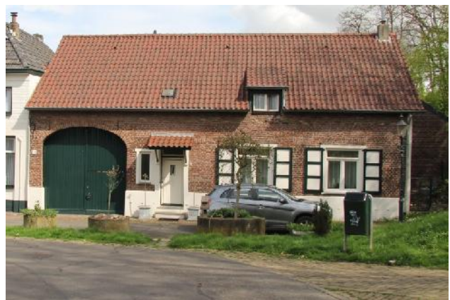
Afb. 15 Brugstraat 11 te Urmond; in de gevel zijn nog sporen aanwezig van de laat middeleeuwse ramen
