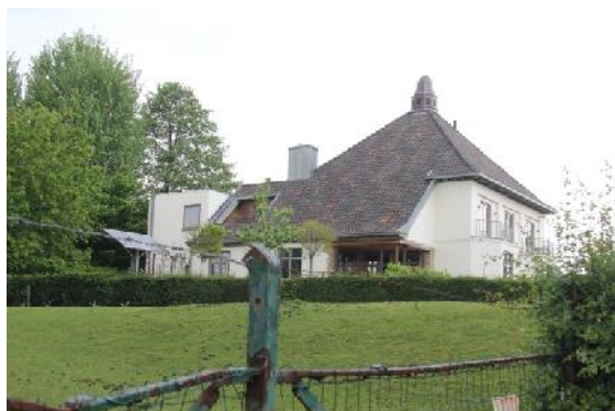
Afb. 22 Voormalige gemeentehuis aan de Raadhuisstraat in Elsloo
