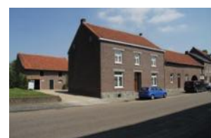
oo, stationsstraat 099, IMG_0
