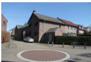
Polderstraat 5 en 7, IMG_2908
