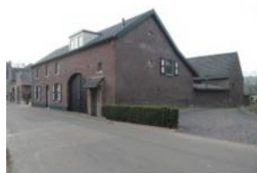
n, Brugstraat 37 en 39, IMG_2
