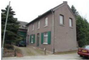
Polderstraat 06 en 08, IMG_2893
