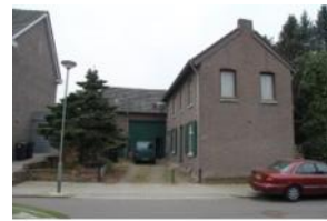
Polderstraat 06 en 08, IMG_2892
