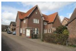
de Maas, Schoorweg 24, IMG_05
