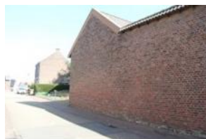
Polderstraat 5 en 7, IMG_2910
