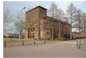
Polderstraat 01 en 03, IMG_2897
