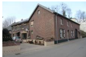
n, Brugstraat 37 en 39, IMG_2
