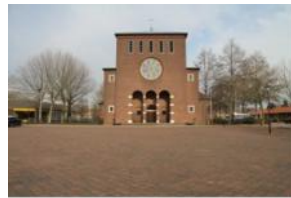
Polderstraat 01 en 03, IMG_2896
