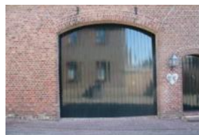
Polderstraat 5 en 7, IMG_2911
