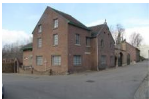
n, Brugstraat 41 en 45, IMG_2
