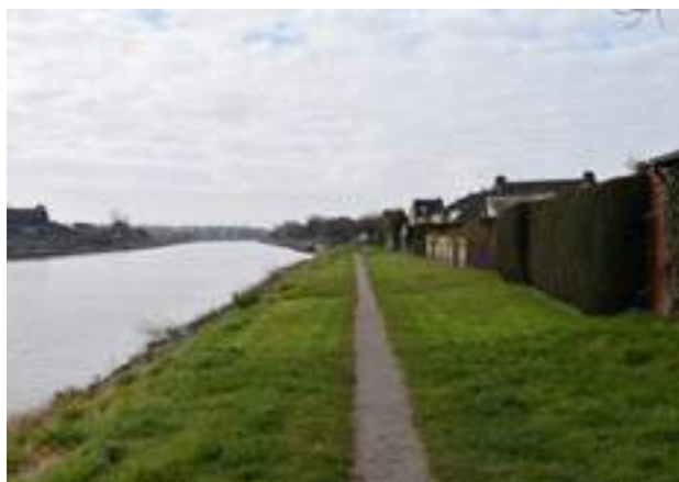
'Achterkantsituatie' in Berg aan de Maas.
