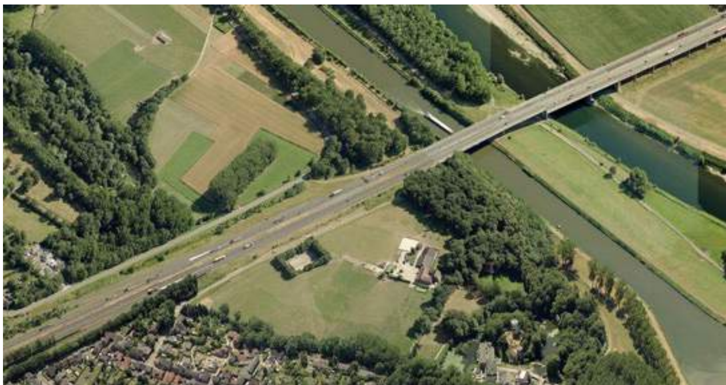
De A76 ter hoogte van de Reekstraat in de huidige situatie
