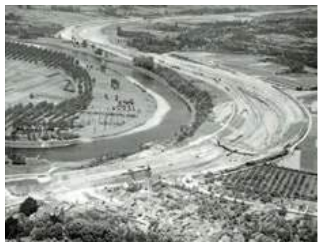
De aanleg van het Julianakanaal, foto is genomen in 1933 ter hoogte van Elsloo (onderin het midden van de foto is de Sint Augustinuskerk te herkennen).
