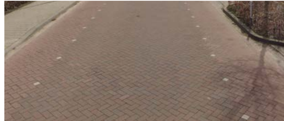
roodbruine betonstraatstenen in twee tinten met vierkante markeringsstenen
