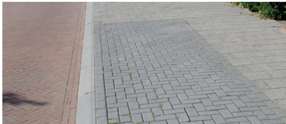
grijze betonstraatsteen (op niveau van het trottoir met overrijdbare band)
