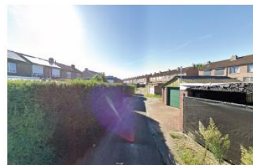
Te slopen garageboxen
