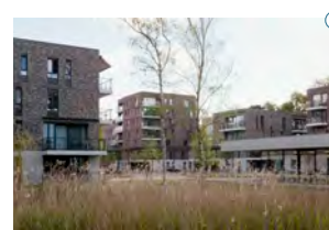
Prins Kavelhof, Brugge Puls Architecten
