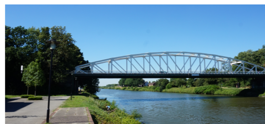
Brug tussen Urmond-Oost en Oud-Urmond over het Julianakanaal
